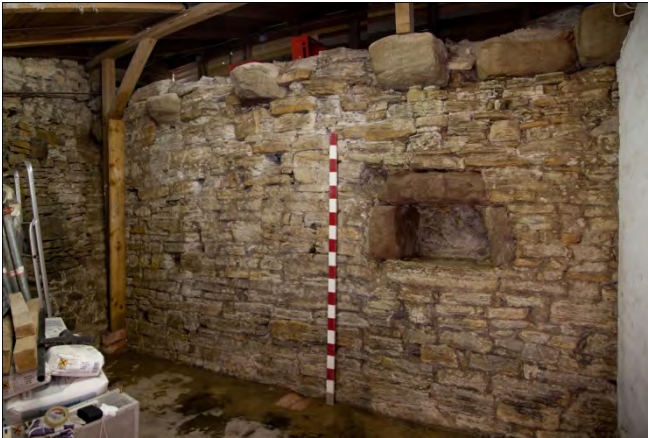
Blick auf die freigelegte Innenmauer des Artillerieturmes. Zu sehen sind die Mauerwerksnische und die Konsolsteine für das Tragwerk des I. Obergeschosses. Rechts das Mauerwerk des Älteren Herrenhauses (UA V – Ost) Foto-Montage aus zwei Einzelfotos.
