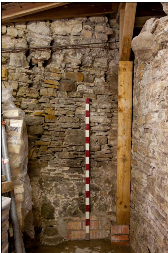
Blick nach Westen. Burg Plesse 83:4, 2010, UA IX, Bereich nördlich des Großen Turmes Mauerwerksbefunde im Bereich des Anstoßes des Artillerieturmes an das Ältere Herrenhaus.
