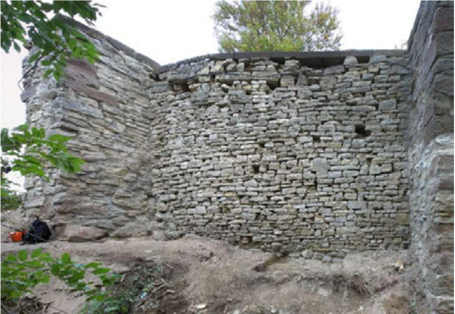
Burg Plesse UA XIII / UA VII: Blick auf das zwischen zwei Stützpfeilern liegende Mauerwerk der Ringmauer. Die Fugen sind völlig ausgewaschen, Steine sind verlustig, insgesamt ist die Mauer in einem sehr schlechten Zustand und muss abgetragen werden.
